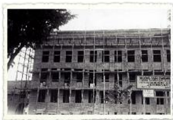
Państwowa Szkoła Morska w budowie.
