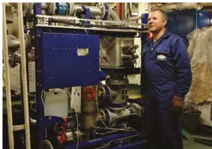
Starszy mechanik „Darowi Młodzieży” Jarosław Borowski podczas odbioru nowo zamontowanej oczyszczalni wód balastowych firmy Alfa Laval. Fot. Marcin Kotowicz
