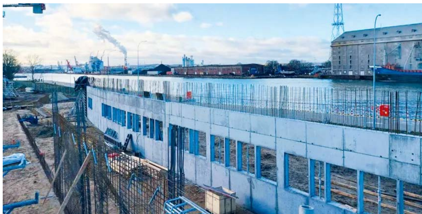
Centrum Offshore Uniwersytetu Morskiego powstaje w sąsiedztwie Twierdzy Wisłoujście
