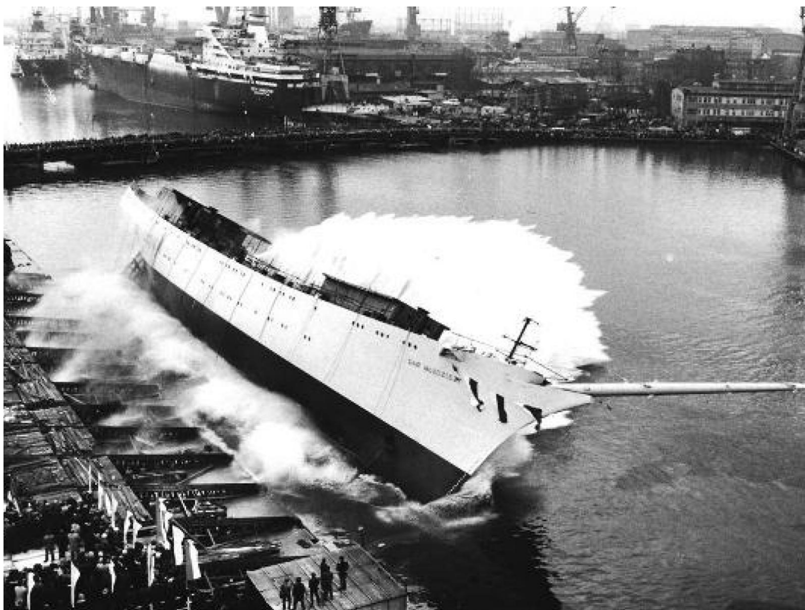
Wodowanie okrętu (zdjęcie archiwalne)//fot. K. Kamiński
