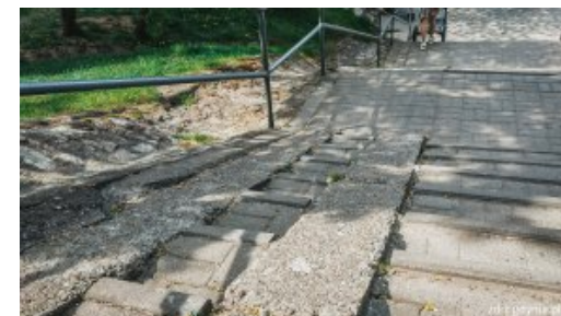
Ruszył remont schodów na Wzgórzu św. Maksymiliana
