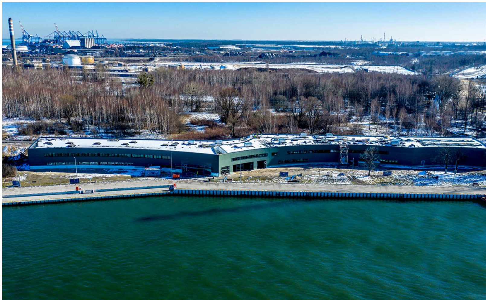
Tak wygląda Centrum Offshore na kilka miesięcy przed finiszem prac budowlanych. Wewnątrz będą działać m.in. specjalistyczne laboratoria dla branży offshore, fot. Uniwersytet Morski w Gdyni / mat. prasowe
