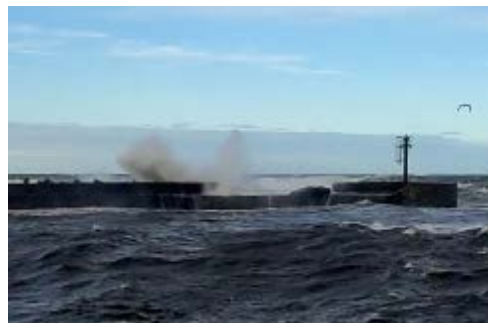
[WIDEO] Sztorm uszkodził falochron w Uście
