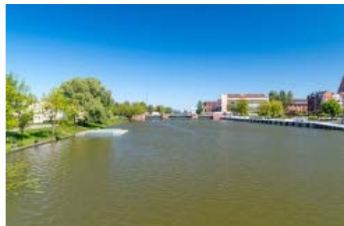
Cofka na Żuławach, wał w Nowakowie przecieka, stan alarmowy w Elblągu
