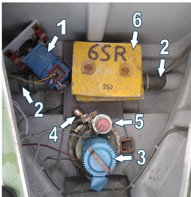
Rysunek 2.16. Fotografia urządzeń w przedziale dziobowym Dorchester Lady gdzie: 1 – napęd steru strumieniowego tunelowego, 2 – tunel, 3 – napęd steru strumieniowego obrotowego, 4 – silnik wykonawczy ustawiający zespół łopatek sterujących kierunkiem strumienia wylotowego, 5 – przetwornik pomiarowy kąta obrotu zespołu łopatek sterujących, 6 – bloki balastowe
