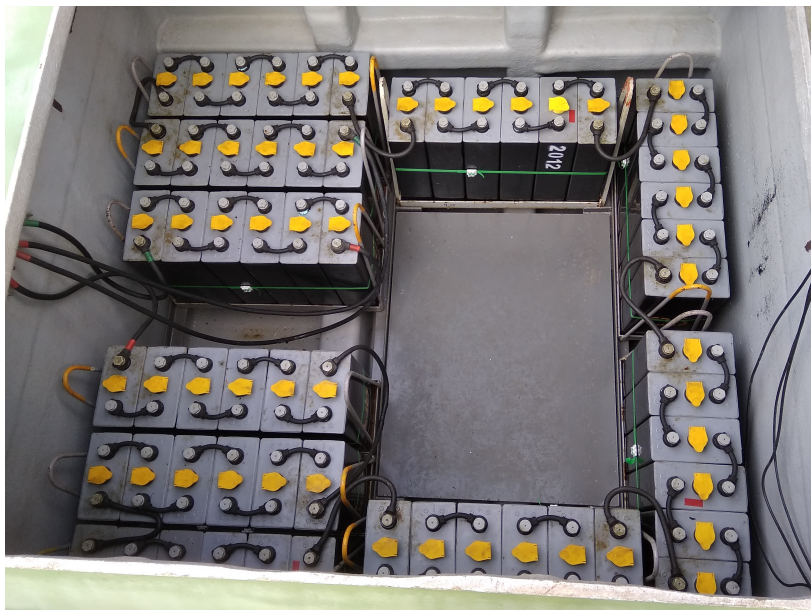
Rysunek 2.10. Bateria akumulatorów 120 V DC . Źródło zasilania modelu Dorchester Lady
